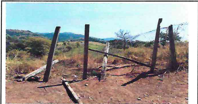
Foto 3: maya perimetral colapsada.
